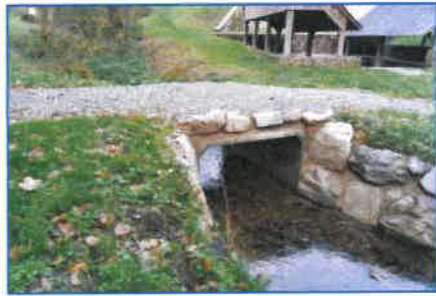
Remplacement d'une passerelle par un pont-cadre à JUIGNE SUR SARTHE sur la Bouchardière
