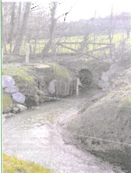
Des travaux ont été réalisés sur 900 mètres du ruisseau la Moyette, à Saint-Germain-le-Fouilloux.
